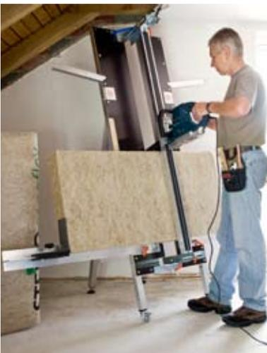
STEICO<sup>canaflex</sup> lässt sich mit einfachen Schneidwerkzeugen bearbeiten. Das spezielle STEICO Dämmstoffmesser eignet sich z.B. hervorragend für den schnellen Zuschnitt von Passstücken.
